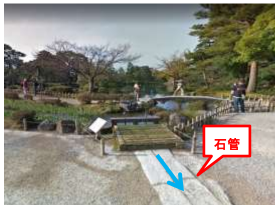
図 3-6 逆サイフォンに使われた石管の遺構
