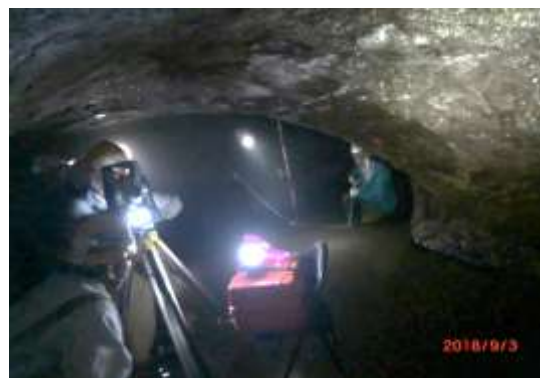
図4-10 岩堰用水トンネルの測量
