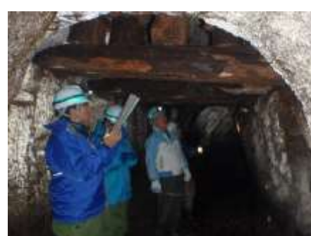
図 4-5 トンネル点検
