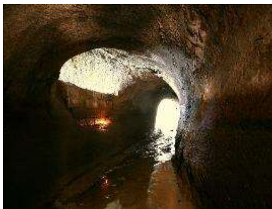
図3 上流部のトンネルと横穴(トンネル左壁 面に窓状に見える)(金沢市提供)
