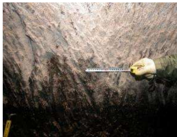
図11 ノミヤツルハシの跡(左上から右下へ、右上から左下へと跡が交差していることから接合点であることがわかる。辰巳用水にまなぶ会)
