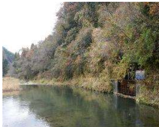
図2 現在の東岩取水口(1855(安政2)年 以来の取水口、金沢市提供)
