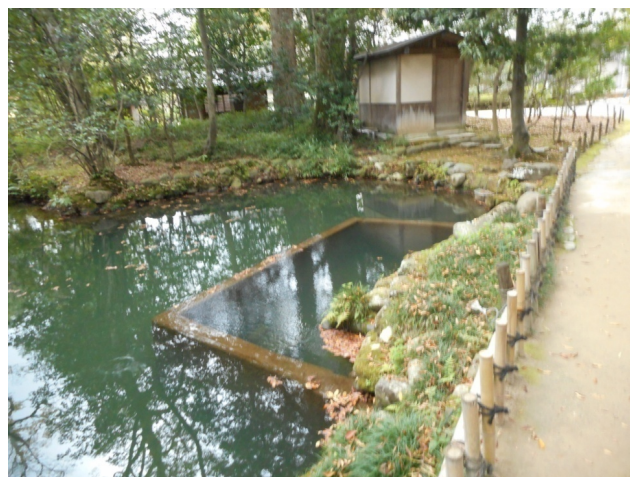
沈砂池に流入 ここで、流速が落ち、砂が沈降する。
